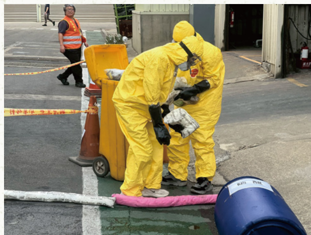
洩漏預防班處理
